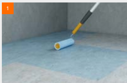
Vorbereitung: Boden grundieren
