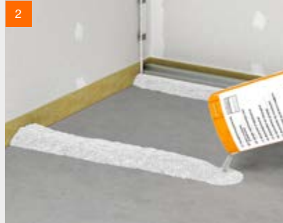
Anlegen der Dämme
