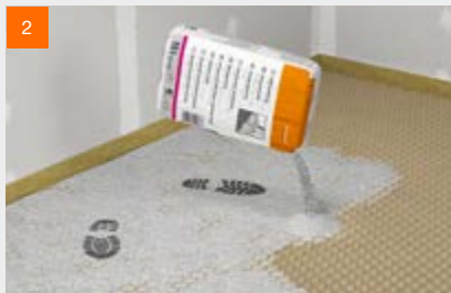
fermacell™ Wabenschüttung einbringen
