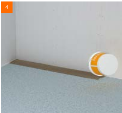
4 Anschliessend hat die fermacell™ Gebundene Schüttung T eine erdfeuchte Konsistenz. Der erste Damm wird angelegt
