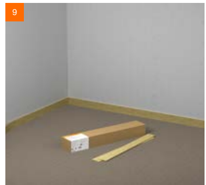
9 Bei Bedarf erfolgt das Anbringen eines Randdämmstreifens
