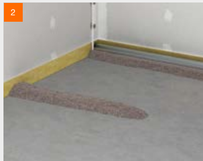
Damm aus fermacell™ Gebundene Splittschüttung anlegen
