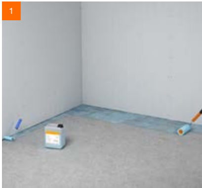
1 Grundierung des Untergrundes mit fermacell™ Tiefengrund
