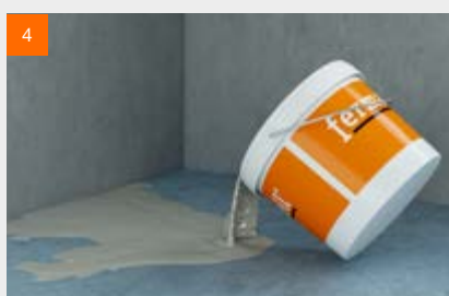
Boden-Nivelliermasse ausbringen und planeben nivellieren
