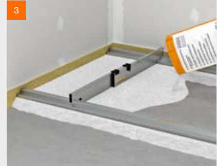
fermacell™ Ausgleichsschüttung einbringen
