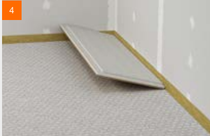
fermacell® Estrichelemente verlegen
