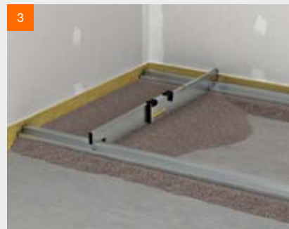
fermacell™ Gebundene Splittschüttung abziehen
