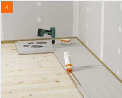
4 Auftragen des fermacell™ Estrichklebers im Falzbereich
