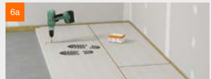
3 Verlegen der fermacell® Estrichelemente
