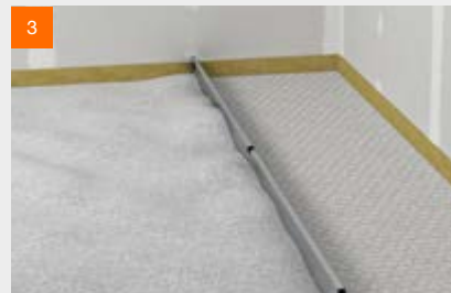
fermacell™ Wabenschüttung abziehen
