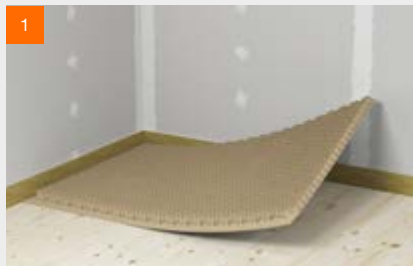
fermacell™ Estrichwabe verlegen
