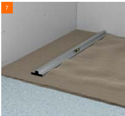
7 ... und auf den leicht verdichteten Dämmen abgezogen
