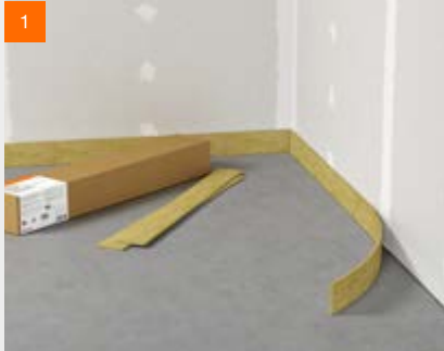
Anbringen der Randdämmstreifen
