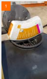
Mischungsverhältnis: 6 Säcke fermacell™ Wabenschüttung + 1 Gebinde fermacell™ Schüttungsbinder
