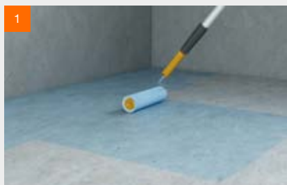
Préparation : appliquer une couche de fond sur le sol
