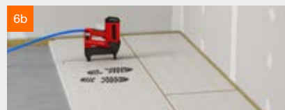
Fixer avec des vis ... ... ou des agrafes divergentes en l'espace de 10 minutes
