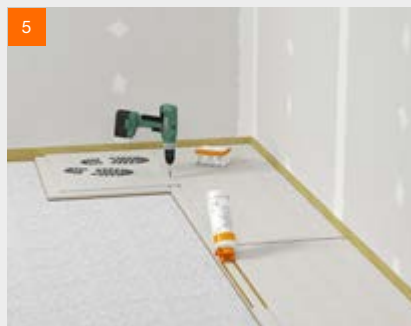
Pose des plaques de sol fermacell® sur le granule d'égalisation fermacell™
