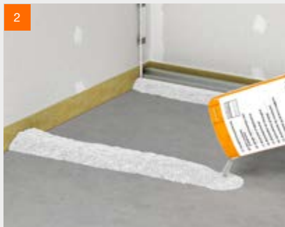
Créer les digues
