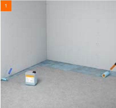
1 Appliquer la couche de fond fermacell™
