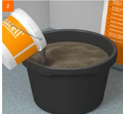
2 Verser dans un récipient le contenu d'un sac complet avec 7-7,5 litres d'eau ...
