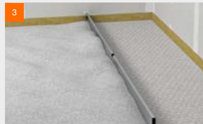
Egaliser les granules Nid d'Abeille fermacell™
