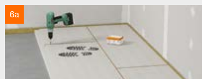
Posez les plaques de sol fermacell®
