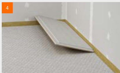
Pose des plaques de sol fermacell®
