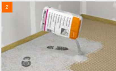
Intégrer les granules Nid d'Abeille fermacell™
