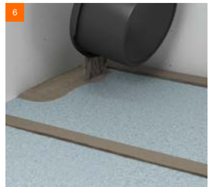
6 Épandre le mortier d'égalisation T fermacell™ entre le deux remblais ...
