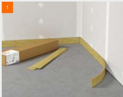
Pose de la bande de rive
