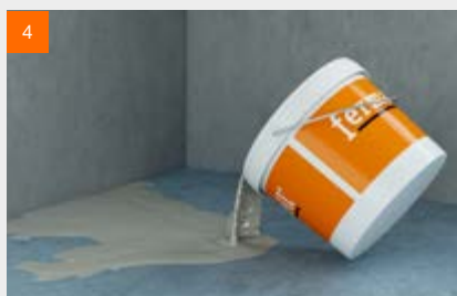
Déverser l'enduit de ragréage et niveler le support
