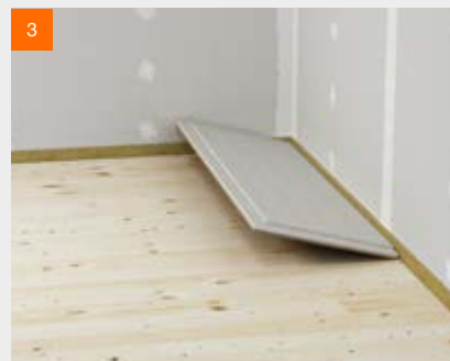
Posez les plaques de sol fermacell®
