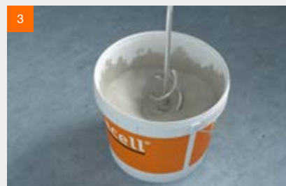
Mélanger à l'aide d'un malaxeur adapté à bas régime jusqu'à obtention d'une masse homogène et exempt de grumeaux
