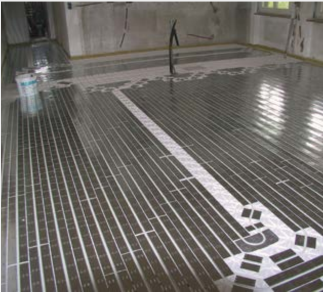
Détail 1 : Plaque de sol fermacell® 2 E 22 sur systèmes de chauffage au sol
