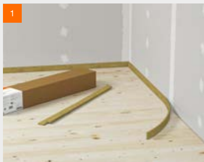
Placer la bande de rive le long des murs
