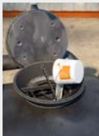
Mélange : 8 sacs de granules Nid d'Abeille fermacell™ ajouter un bidon de liant pour gravillons fermacell™
