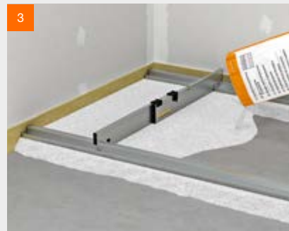
Epandage du granule d'égalisation fermacell™
