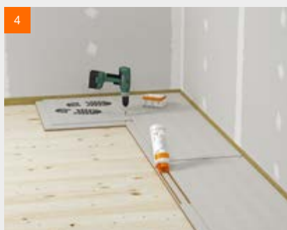
Appliquer la colle fermacell™ sur les battues
