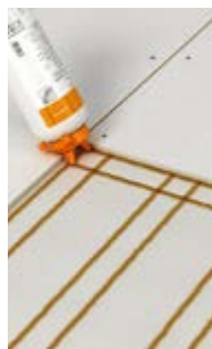
Cordon de colle le long du bord de la plaque
