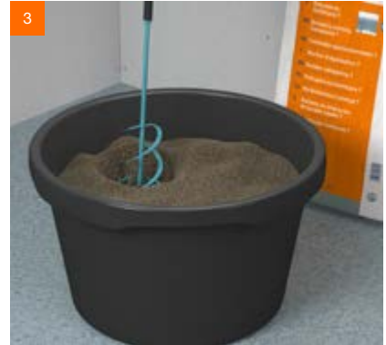
3 ...et mélanger soigneusement le tout. Pour des hauteurs d'égalisation inférieures à 20 mm, il est possible d'augmenter la quantité d'eau jusqu'à 8,5 litres au maximum par sac
