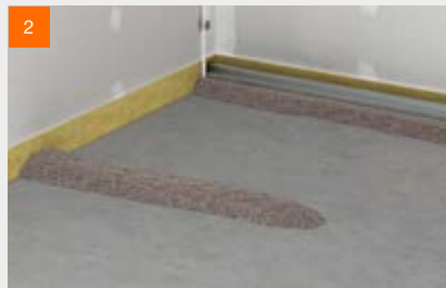
Créer une digue de gravillons fermacell™ liés
