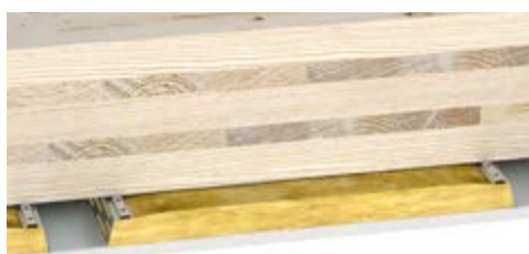
Planchers en panneaux de bois massif multicouches avec plafonds suspendus
