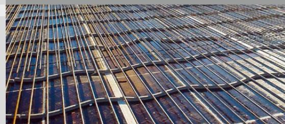
Bei dünnen Tragstäben ist die Durchbiegung beim Betoniervorgang zu beachten. Bei schwerer Bewehrung ist die Druckbelastung der Abstandhalter zu überprüfen.
