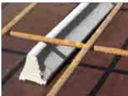
Bei waagrechter Verlegung flache Seite stets nach unten.
