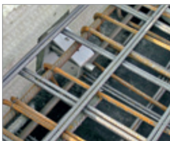
Fuge mit installiertem Dornteil und Brandschutzmanschette
