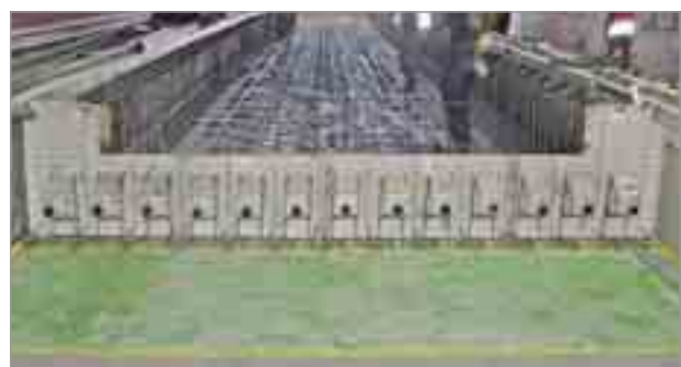
Komplettes Abschalsystem mit Egcodorn® und Stremaform® als Dehnfugenabstellung fertig montiert und zur Baustelle geliefert.
