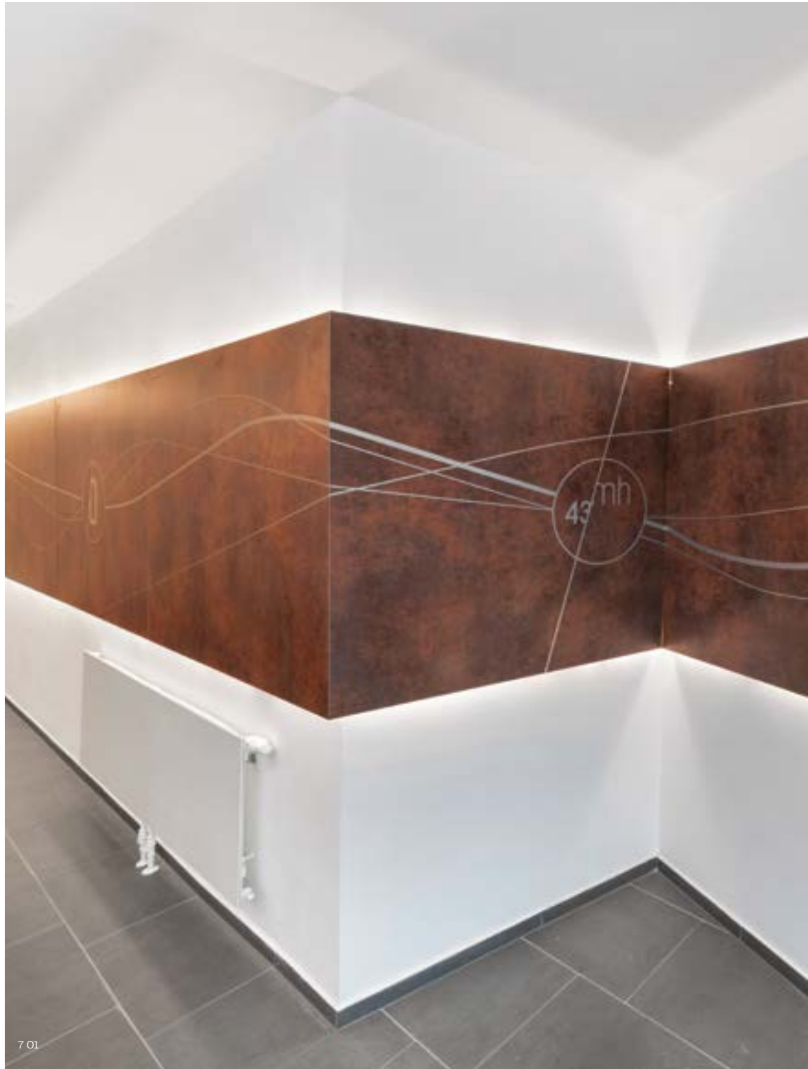
7 01 Dekorative Wandverkleidung mit Hinterlüftung
