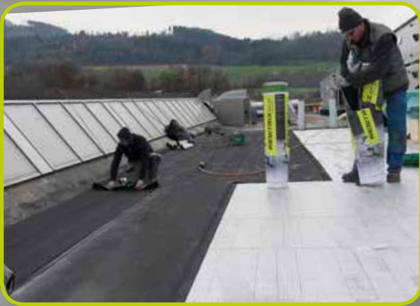
Hinterlaufsicherer Anschluss ohne Materialwechsel
