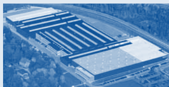
Hörmann KG Eckelhausen, Allemagne
