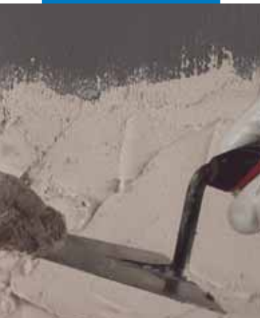
Aufbringen eines Putzes auf Eco Prim Grip
