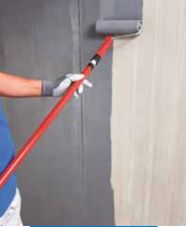
Aufrollen von Eco Prim Grip auf Beton
