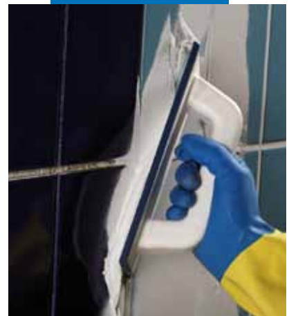
Einfügen von Kerapoxy CQ mit der MAPEI- Fugenbrett
