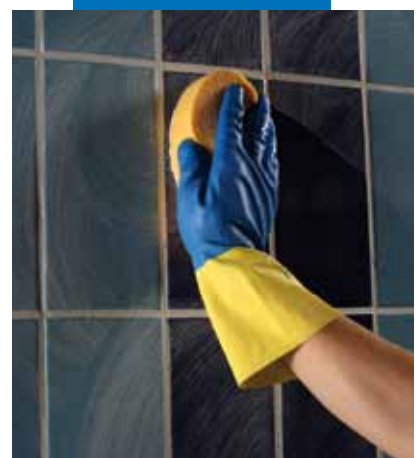
Säubern und Endbearbeitung mit einem harten Zelluloseschwamm
