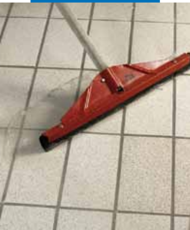
Überschüssiges Waschwasser wird mit einem Gummischieber abgezogen
