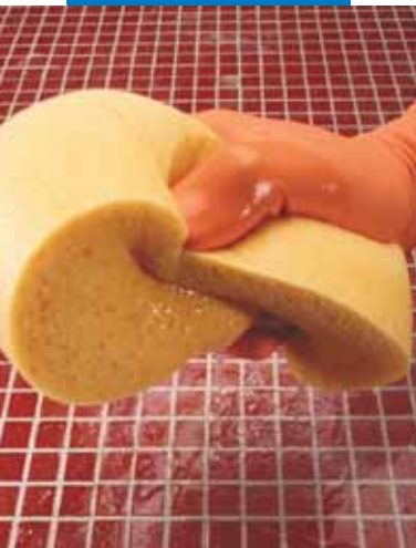
Anfeuchten der Oberfläche vor der Reinigung
