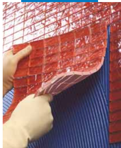
Ansetzen von Glasmosaikplatten an der Wand
