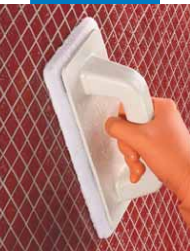
Reinigen der Glasmosaik-Oberfläche mit einem feuchten Scotch Brite®-Pad
