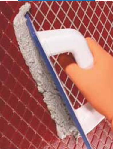
Verarbeitung von Kerapoxy Design mittels Gummifugscheibe
