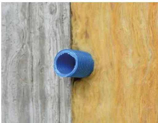
*Glaswolle ist schmiegsam und sehr anpassungsfähig. Sie ist die beste Lösung für Renovationen oder Neubauten von Fassaden mit Unebenheiten und viel Anpassungsarbeiten.*
