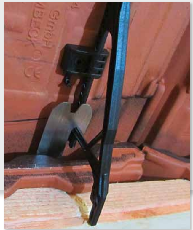
DACHSTICK® nach unten befestigen.
