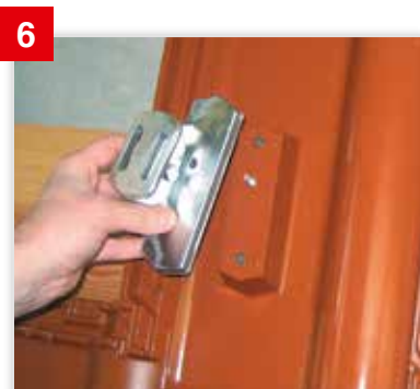
6 Jetzt kann der Solarträgeraufsatz mit der Trägerpfanne verschraubt werden.
