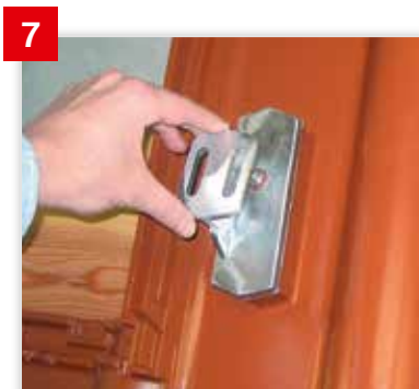
7 Anschließend den montierten Solarträgeraufsatz nach Dachneigung ausrichten.
