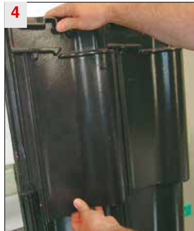
Dachziegel eindecken und andrücken. Fertig!
