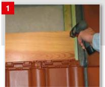
Holzbohle in Stärke der Traglatte (ca. 160 mm breit) direkt oberhalb der Dachziegel in die Konterlattung befestigen.
