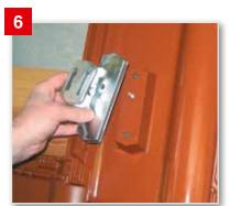
Jetzt kann der Solarträgeraufsatz mit der Trägerpfanne verschraubt werden.
