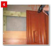
Die Alu-Solar-Trägerpfanne mit den beigefügten Edelstahlschrauben an der Traglatte befestigen.
