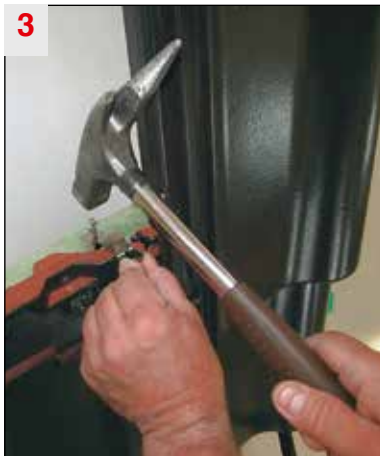
... und von oben in die Traglattung einschlagen.
