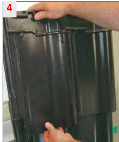
Dachziegel eindecken und andrücken. Fertig!
