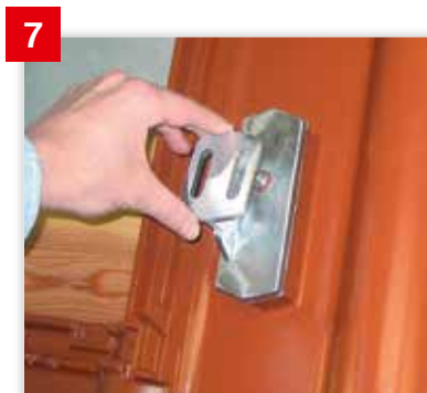
7 Anschließend den montierten Solarträgeraufsatz nach Dachneigung ausrichten.
