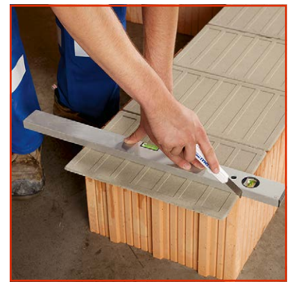
3. Bei Bedarf zuschneiden
