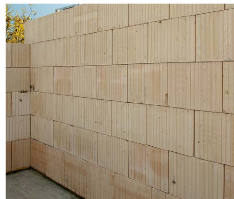
Optimiertes, plangeschliffenes und SIA-konformes Backsteinsystem «EcoModul» mit 1-mm-Dünnbettmörtelfuge.
