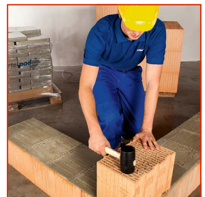
6. Mauerstein ausrichten
