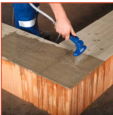
4. «maxit mörtelpads» bewässern
