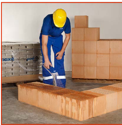
1. Mauersteine befeuchten
