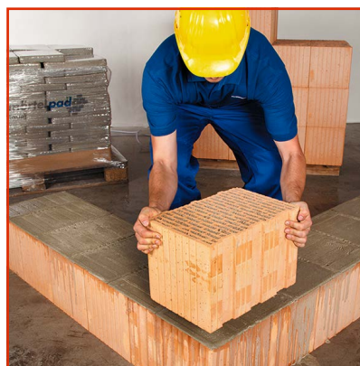
5. Mauerstein vollflächig auflegen
