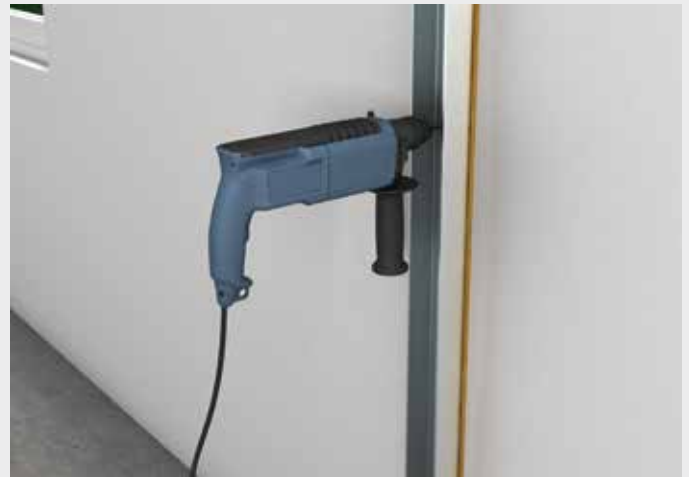
Befestigung der CW-Profile an Massivwand auf Dämmstreifen
