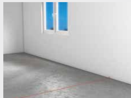
Anlegen der Wandachse mit Schnurschlag oder Hochbaulaser
