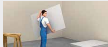
Einzelne fermacell Gipsfaser-Platten hochkant tragen
