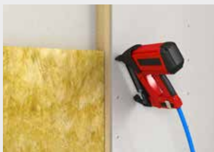
Klammern auf Holzunterkonstruktion
