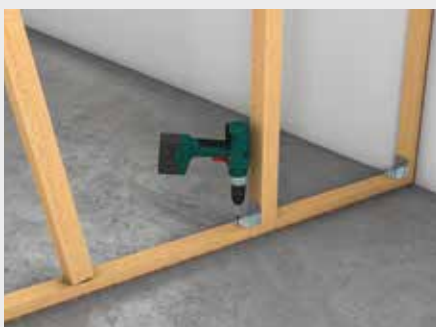
Montage der Holzständer mit Stiftnagel oder Stahlwinkel
