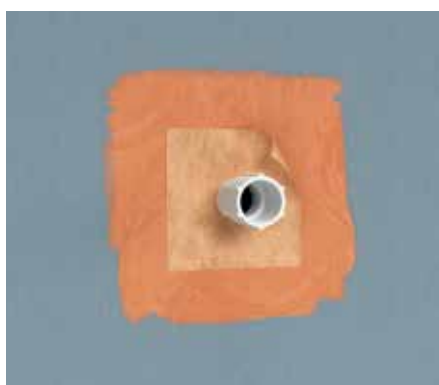
Zur Abdichtung von Rohrdurchführungen die Wanddichtmanschette in die noch feuchte fermacell Flüssigfolie einbetten und direkt erneut überstreichen, Trocknungszeit: mind. 1 Stunde
