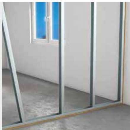
Montage der CW-Ständerprofile
