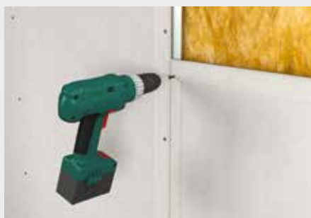
Schrauben auf Stahlunterkonstruktion
