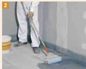
2 ... und Bodenbereich per Rolle auftragen
