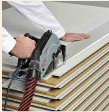
Absägen des überstehenden Falzes für die erste Verlegereihe
