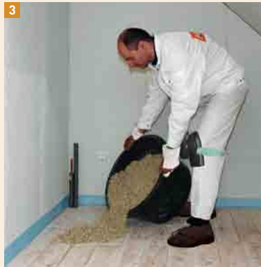
3 Anschließend hat die gebundene Schüttung eine erdfeuchte Konsistenz
