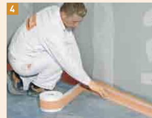
4 In die feuchte Flüssigfolie das FERMACELL Dichtband eindrücken
