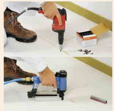
Befestigen durch Verschrauben ... ... oder Spezial-Spreizklammern innerhalb von 10 Min.
