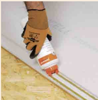
Auftragen des FERMACELL Estrich-Klebers im Falzbereich
