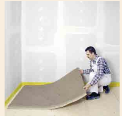
FERMACELL Estrich-Wabe verlegen
