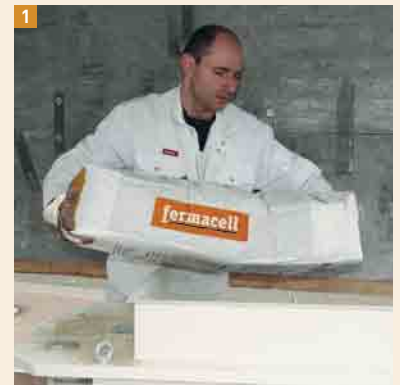
Der gesamte Sackinhalt ist in einem geeigneten Mischgerät, z. B. Handmischer, Estrichpumpe oder Zwangsmischer, ...
