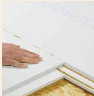
Verkleben der Elemente mit vollständig gefüllten Fugen
