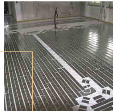
Beispiel 1: FERMACELL Gipsfaser Estrich-Element 2 E 22 auf Warmwasser-Fussbodenheizung
