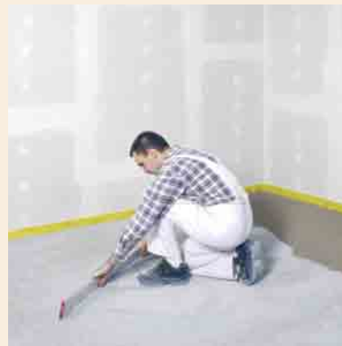
FERMACELL Wabenschüttung abziehen
