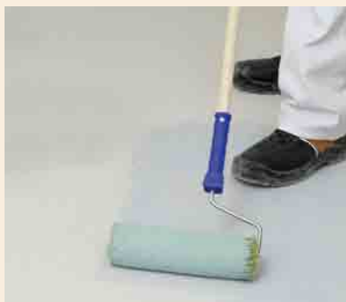
Vorbereitung: Boden grundieren
