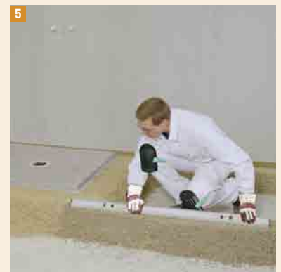
Der zweite Damm wird auf dem Niveau des ersten geschüttet und ausgerichtet
