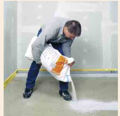
Anlegen der Dämme
