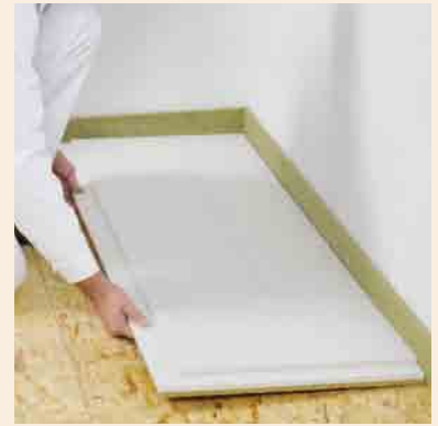
Verlegen der FERMACELL Estrich-Elemente
