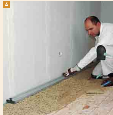
4 Der erste Damm wird angelegt und ausgerichtet
