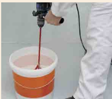
Mit geeignetem Rührgerät bei langsamer Drehzahl anmischen, bis eine homogene, klumpenfreie Nivelliermasse entsteht
