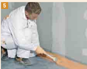
5 Dichtband direkt nach dem Eindrücken mit FERMACELL Flüssigfolie überstreichen
