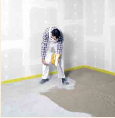
FERMACELL Wabenschüttung einbringen
