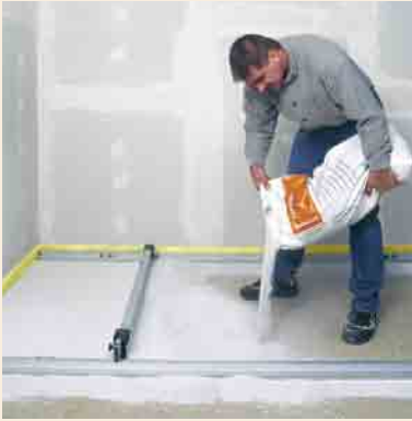
FERMACELL Ausgleichsschüttung einbringen
