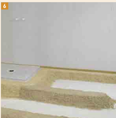
6 Warten bis die Dämme angezogen haben (ca. 20 Minuten)
