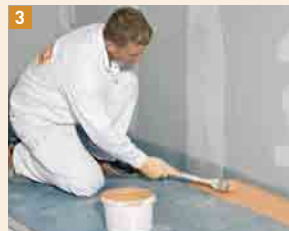
3 FERMACELL Flüssigfolie in die Ecke auftragen
