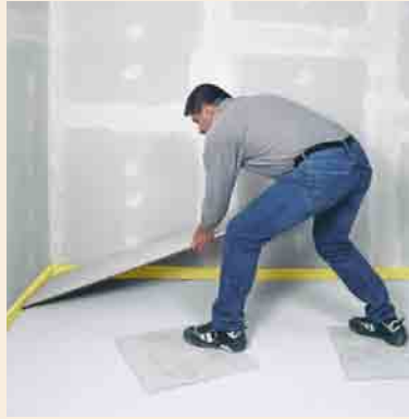
Verlegen der FERMACELL Estrich-Elemente auf FERMACELL Ausgleichsschüttung
