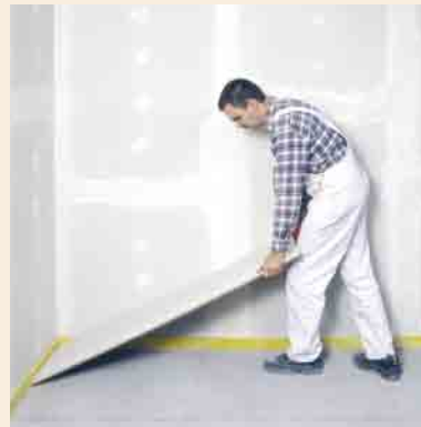
FERMACELL Estrich-Elemente verlegen
