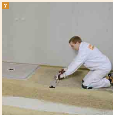
7 Ist die gebundene Schüttung zwischen den Dämmen ausgebracht, wird abgezogen
