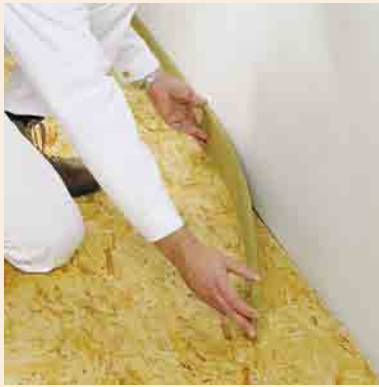
Randdämmstreifen verlegen und in den Ecken stumpf stossen
