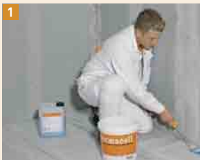
1 FERMACELL Tiefengrund im angrenzenden Wandbereich ...
