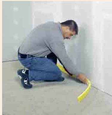
Anbringen der Randdämmstreifen
