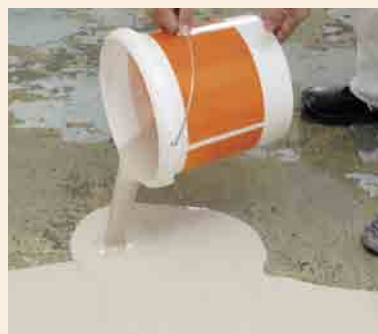
Boden-Nivelliermasse ausbringen und planeben nivellieren
