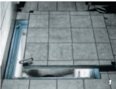
1 Typ BV eingebaut in Putzschacht
