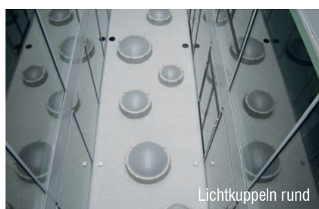
Standard Lichtkuppeln, Hauptbahnhof, Bern
