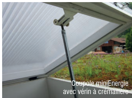
Utilisation d'une plaque alvéolaire sur une coupole
