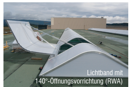
Lichtband mit Öffnungsvorrichtung (RWA) Hub 100 cm
