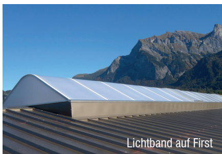
Lichtband mit Öffnungsvorrichtung (RWA) Hub 100 cm
