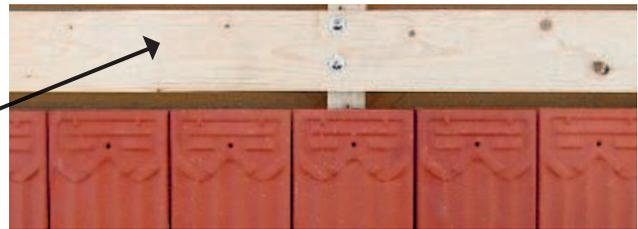
**Wichtig:** Die Dachlatte wird bis Ausserkante Konterlatte zurückgeschnitten. Zusätzlich wird ein Stück Dachlatte ca. 20 cm seitwärts in die Konterlatte genagelt.
