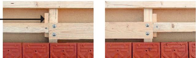
**Wichtig:** Das oberste TBS Schraubenloch muss über der Konterlattung eingemittet sein. Bei einer Durchdringung der Schrauben durch das Unterdach muss dies gem. Norm SIA 232/1, (Ziff 2.2.10.3) dicht sein. Der SH AGZ Sicherheitshaken kann jetzt mit mindestens drei 8x80 mm TBS Schrauben durch die Dreischichtplatten in die Konterlatte befestigt werden.
