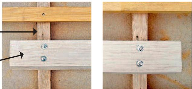
An der Stelle, an der der SH AGZ Sicherheitshaken montiert wird, wird eine TBS Schraube schräg unten in die Stirnseite des konischen Traufbrettes platziert.
