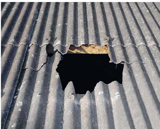
Rupture de panneaux en fibrociment ondulés
