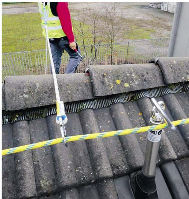
Système à corde temporaire avec corde à noyau de retenue EN 1891
