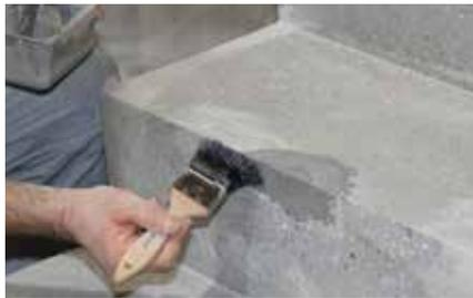
**Reprofilage PSS:** les efflorescences, retassures, nids etc. sont substantiellement restaurés. Les endroits améliorés sont retouchés et leur aspect est ajusté.
