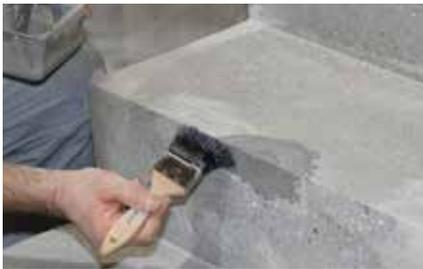
**PSS Reprofilierung:** Ausbrüche, Lunker, Nester, usw. werden substanziiell aufgearbeitet. Die ausgebesserten Stellen werden retuschiert und optisch angepasst.
