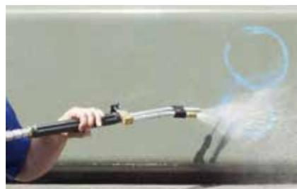
**Polysaccharid-Technologie:** Gerade an historischen Fassaden zeichnet sich das unsichtbare Opferschichtsystem durch seine rückstandslose Graffiti-entfernung aus.
