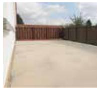
12. Abschließend kann das Abdichtungssystem Triflex BTS-P aufgebracht werden.
