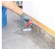
6. Anschließend Triflex Pox R 100 gleichmäßig an Details und ...
