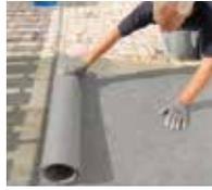
3. Die Triflex Entkopplungsbahn passgenau zuschneiden und aufbringen.
