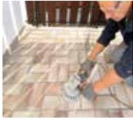
1. Untergrund vorbereiten, Unebenheiten beseitigen und lose Teile entfernen.
