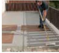
4. Mit ausreichendem Druck die Entkopplungsbahn einrollen.
