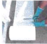
2 Triflex Spezialvlies-zerschnitte vorbereiten.
