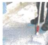
9 Eine zweite Schicht Triflex ProTerra wird aufgebracht.
