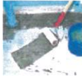
1 Wandanschluss und Fläche grundieren.
