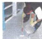
10 Die Nuttschicht Triflex ProTerra wird auf Details und Fläche aufgebracht.
