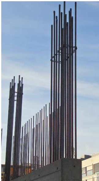
Erdbebenwand mit konzentrierter Randbewehrung
