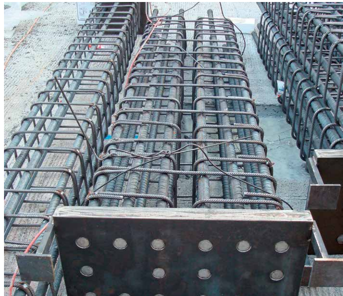
BARTEC® Spezialplatte CT als Mehrfach-Endverankerung
