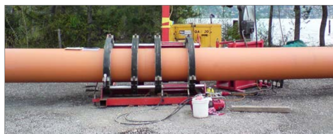
Heizelementstumpfschweißen
