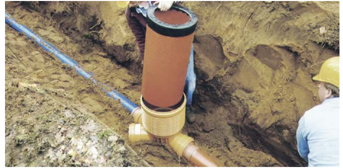
4 Aufsetzen der Teleskopmanschette.
