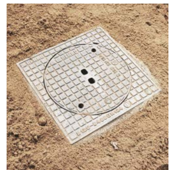
7 Komplett verlegter Schacht.
