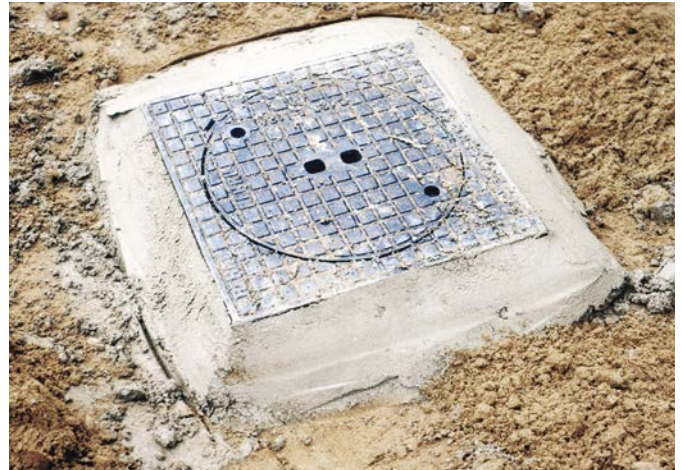
7 Hergestelltes Betonaufleger.
