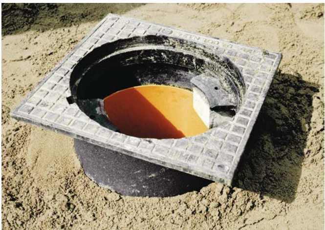
6 Aufgesetzter Gussrahmen mit ca. 60 mm dicken Distanzklötzen.
