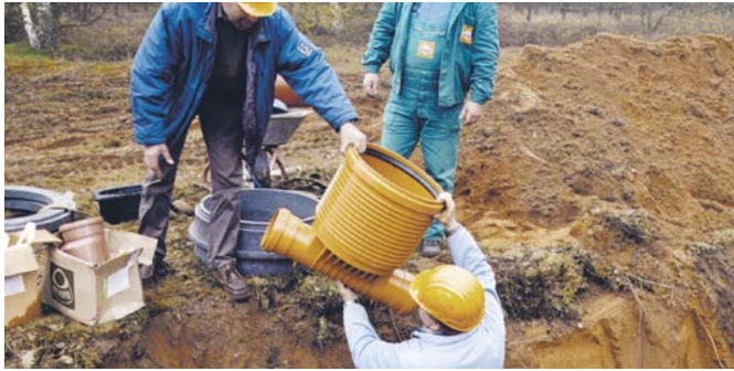
1 Einbringen des Schachtbodens in den Rohrgraben.
