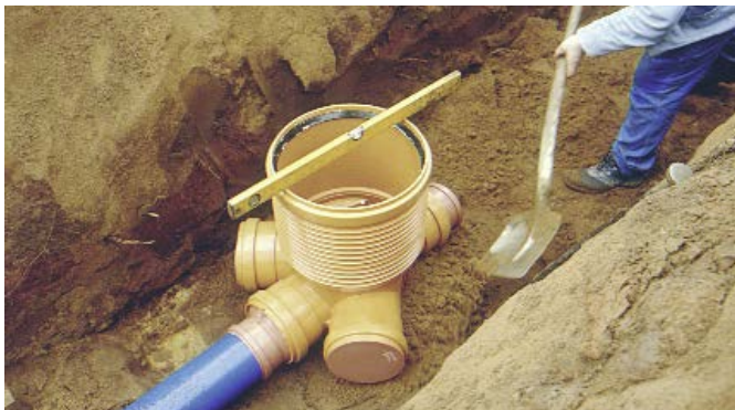
2 Ausrichten des Schachtbodens im Rohrgraben und Anschluss der Rohrleitung.
