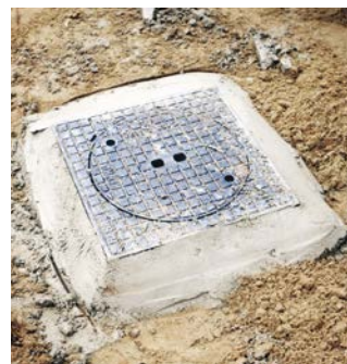
6 Hergestelltes Betonaufleger.
