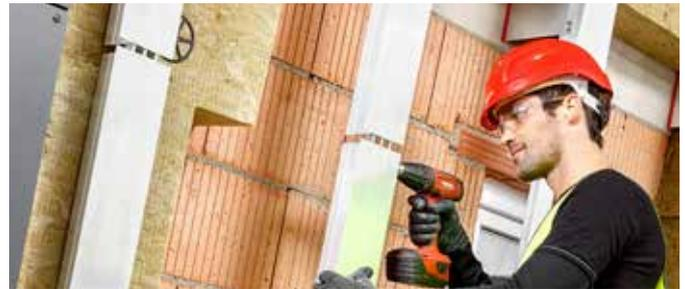
Geschossübergreifendes System für Gebäude bei denen der Untergrund zwischen den Geschossdecken nur sehr geringe Haltewerte bietet.
