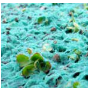
ND Hydroseeder - Sprösslinge sind mit Mulchschicht besprüht
