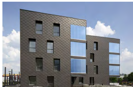
Mediathek und Wohnungen in Nantes (Frankreich), Architekt: Rocheteau et Saillard
