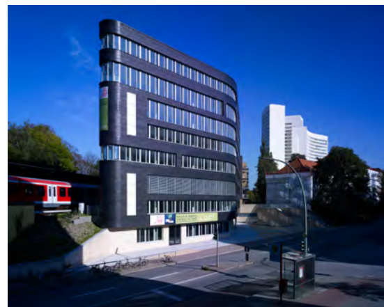
Bürogebäude in Hamburg, Architekten: SEHW
