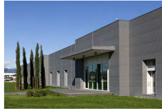
Firmensitz in Mornico All Serio (Italien), Architekt: Alberto Bertasa
