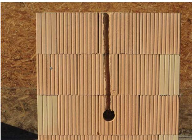
In der Planung ist darauf zu achten, dass die Schlitze vertikal ausgeführt werden. Alle Installationsschlitze müssen mit wärmedämmendem Leichtmauermörtel geschlossen werden.
