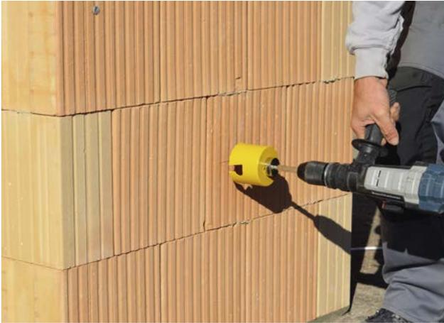
Elektrodosen müssen mit einem Dosenbohrer gefräst und nicht gespitzt werden.
