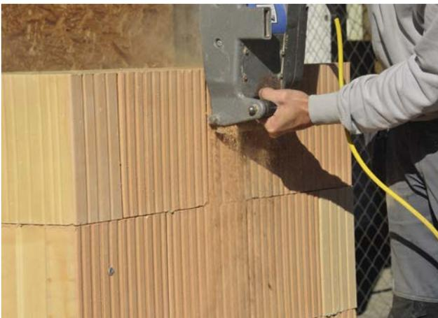
Um ein sauberes Schnittbild zu erhalten und das Öffnen der Kammern zu minimieren, eignen sich Mauernutfräsen oder Diamant-Schlitzgeräte.
