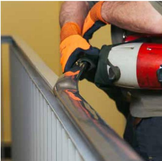
Chauffer la main courante de manière régulière par pistolet à air chaud avec tuyau flexible.
