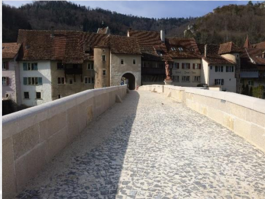
St.-Neppomuk-Brücke in St. Ursanne (saniert)
