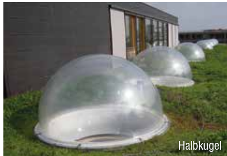
Lichtkuppeln mit RWA-Steuerung, Rolex Learning Center, Lausanne
