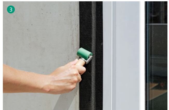
Zum Schluss gesamte Klebung mit Hartgummiroller gut anrollen.
