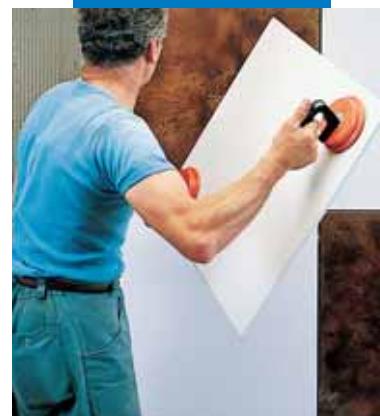
Ansetzen großformatiger KERAION-Platten
