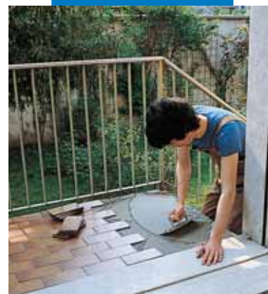
Fliesenverlegung mit Kerabond T+Isolastic
