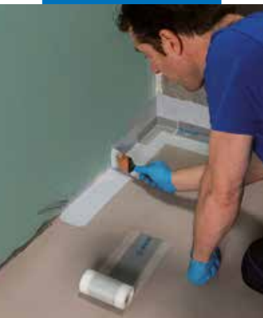
Application de Mapeband PE 120 avec Mapegum WPS
