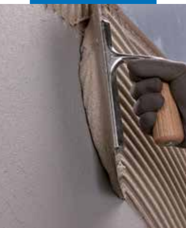
Application de revêtement de sol avec Ultramastic III
