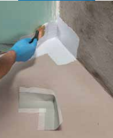
Application d'une pièce d'angle de 90° de Mapeband PE 120 avec Mapegum WPS
