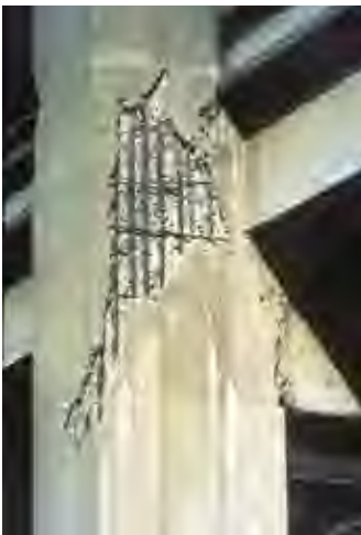
Typisches Beispiel einer klassischen Betonabplatzung. Die Tragfähigkeit einer Überlappung ist hier nicht mehr gewährleistet.
