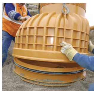
Aufsetzen des Konus bzw. nächsten Schachtelementes
