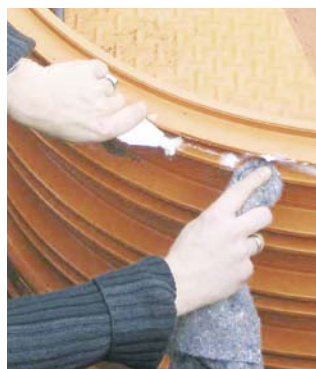
Aufbringen des Gleitmittels
