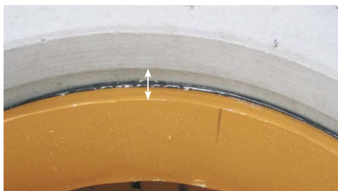
Abstand Konus Betonauflagerung
