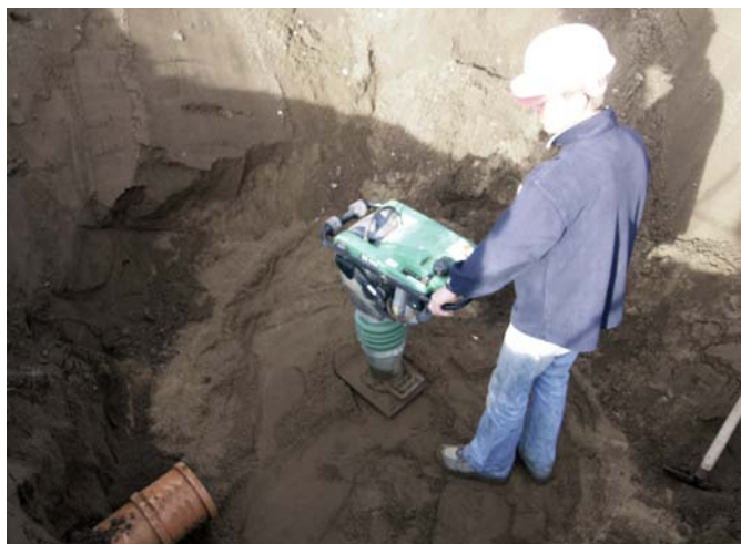
Herstellen des Schachtauflagers
