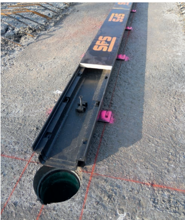
2. Spicken der Rinnenflucht und Markieren der Bohrlöcher
