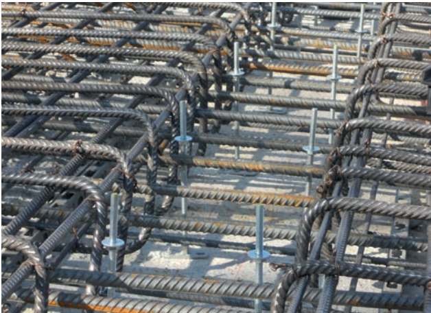
4. Verlegen der Bewehrung und Montage der Gewindestäbe
