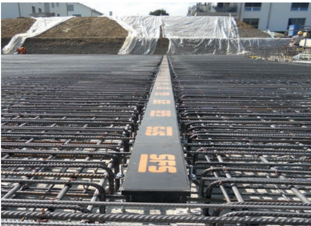
6.1. Rinnenstrang fertig montiert und vorbereitet zum Betonieren
