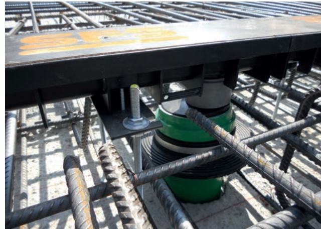
5. Positionierung der Rinne auf fertige Höhe und Bohren der Abflußlöcher
