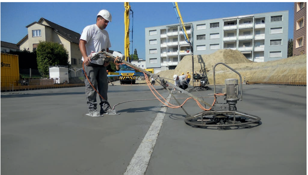
7. Betonieren, abtalschieren auf Oberkante Bretteinlage und längsseitiges Fasen an Zargenkante
