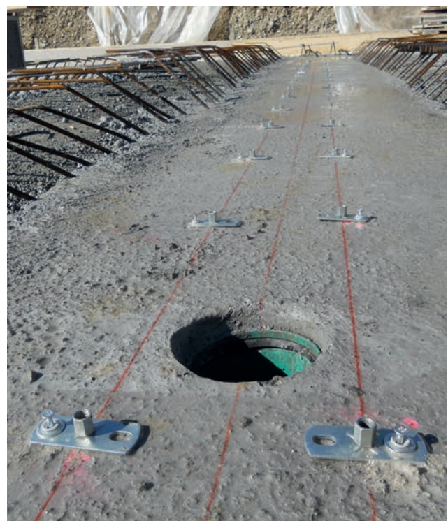
3. Bohren der Befestigungslöcher, Montage der Stützfüsse auf Konstruktionsbeton
