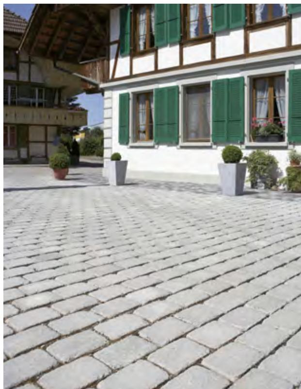
Abbildung 19: Pflastersteine mit aufgeweiteten Fugen
