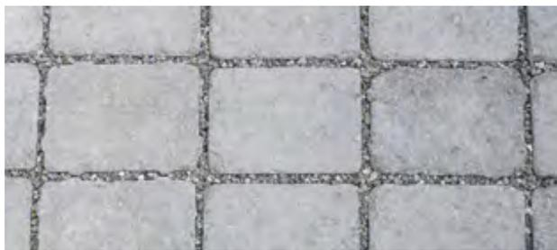
Abbildung 12: Korrekte Fugenausbildung bei Ökopflastersteinen mit aufgeweiteten Fugen
