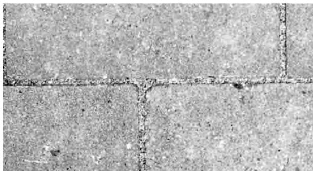
Abbildung 5: Wirksamer Pflasterbelag dank korrekter Verfugung
