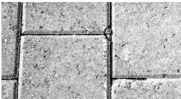
Abbildung 6: Kantenabplatzungen infolge fehlender Verfugung
