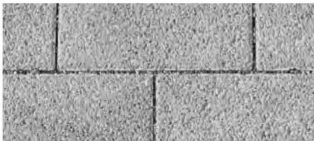
Abbildung 11: Wirksamer Sickersteinbelag dank korrekter Verfugung
